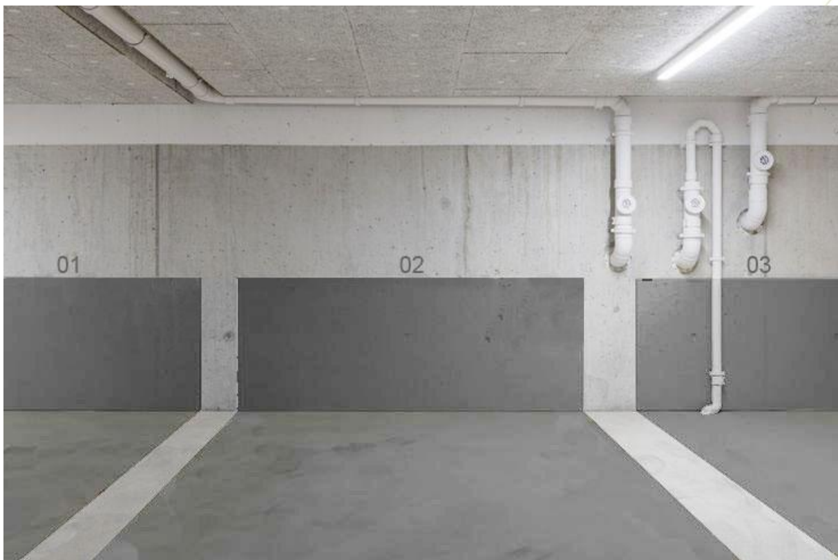
Boden mit Stellplatzmarkierung und Nummerierung
