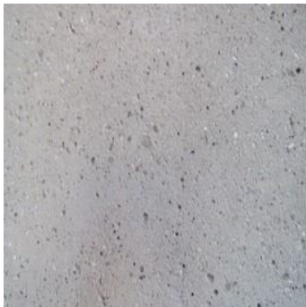
Ortbeton für Wege Innenhof
